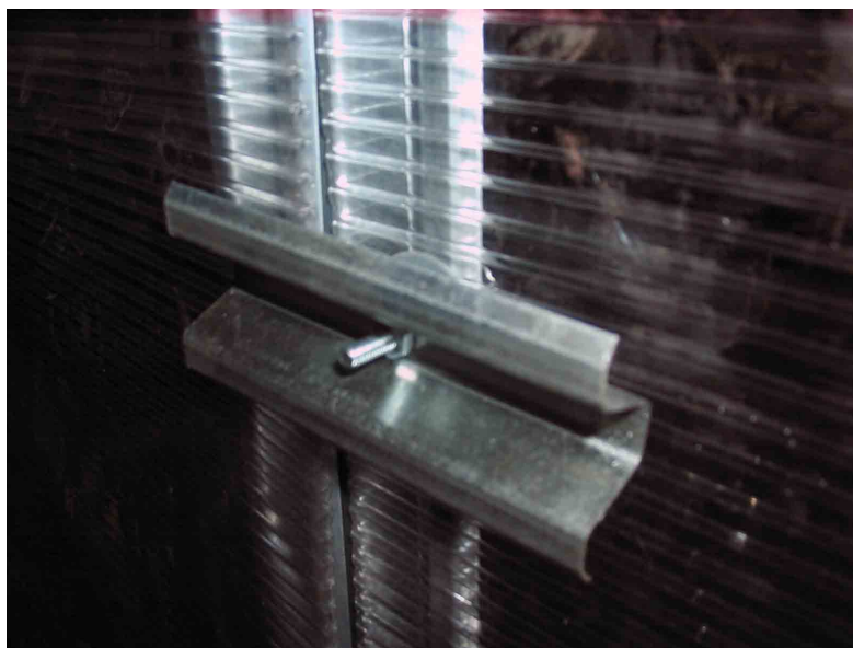
Фото 9 Крепление СПК и вертушка двери
