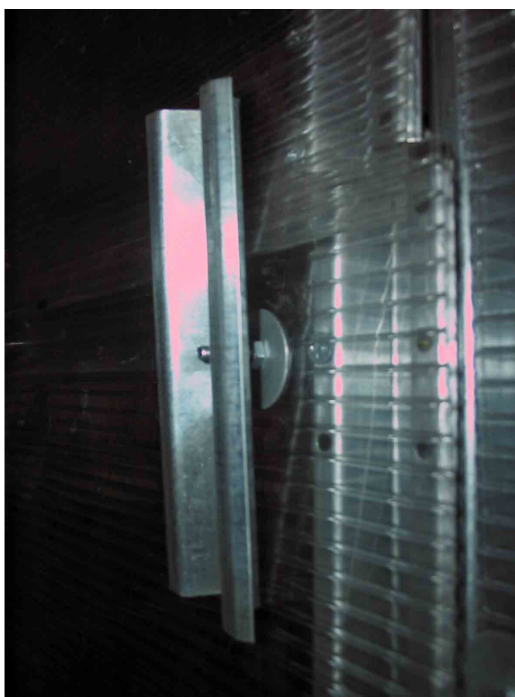
Фото 10 Крепление СПК и вертушка форточки
