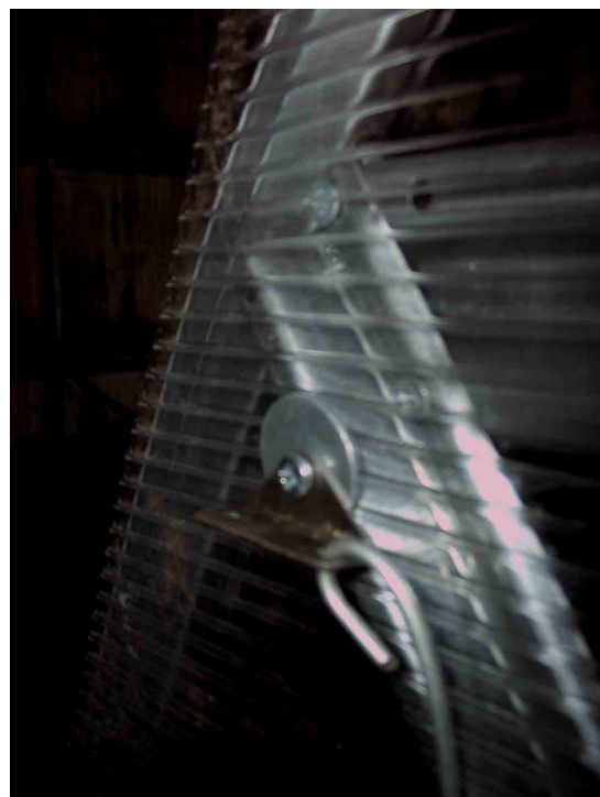
Фото 7 Крепление СПК и уголка поз. 23 с крючком двери
