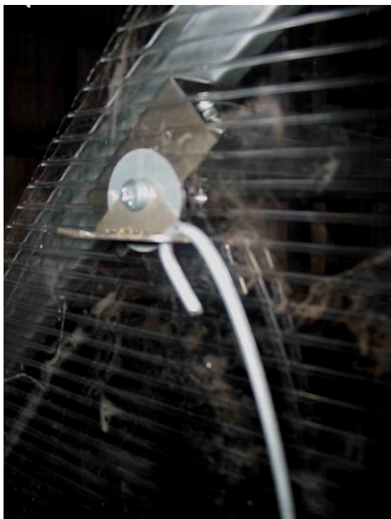
Фото 6 Крепление СПК и уголка поз. 23 с крючком форточки
