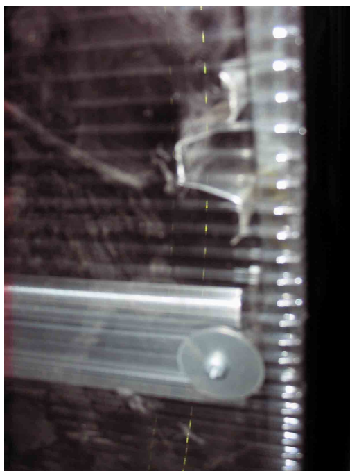
Фото 3 Крепление СПК к нижней поперечине торца поз. 5
